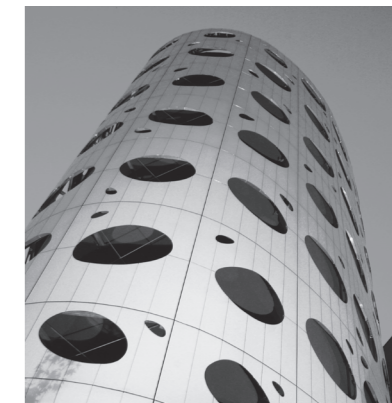
Une architecture futuriste avec revêtement en ALUCOBOND® : l'Hôtel Lindner Seepark à Klagenfurt, Autriche.
