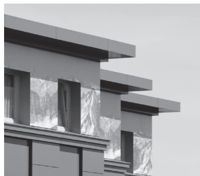
Réaménagement et maintenance à long terme pour des mesures de modernisation économiques avec l'ALUCOBOND® : la Höxterstraße à Hagen, Allemagne
