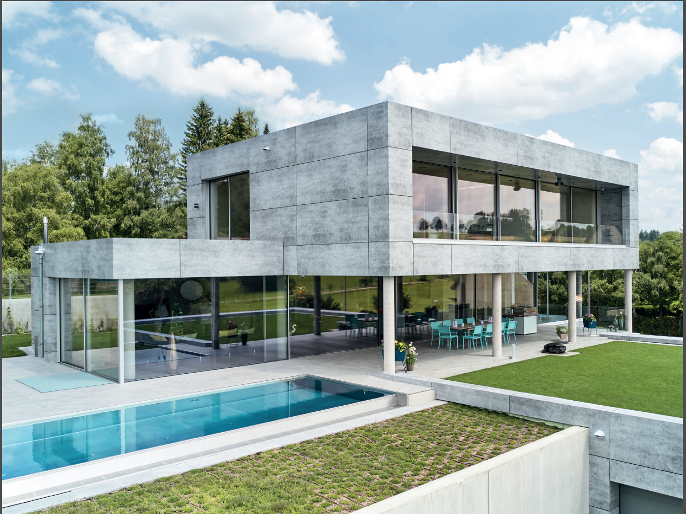
Villa Black Forest, Allemagne | Matériau/Materiale: ALUCOBOND® PLUS vintage Rough Concrete | Architecte/Architetto: Rebholz Architekten Transformateur/Trasformatore: Holzbau Leopold | © swissFineLine AG
