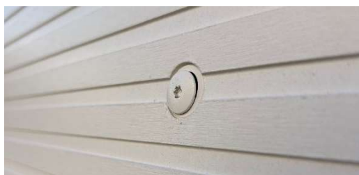
Figure 9 – Forêt fraiseur pour panneaux PATINA INLINE et vue du panneau fraisé
