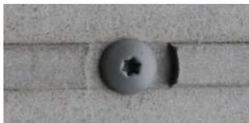
Figure 9 – Forêt fraiseur pour panneaux PATINA INLINE et vue du panneau fraisé
